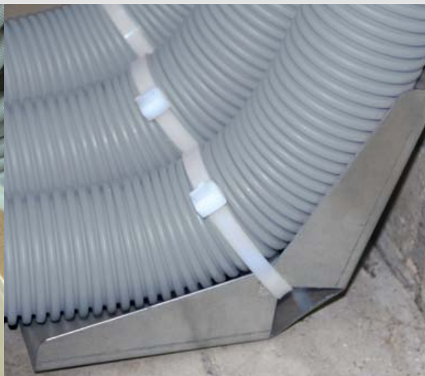
Prowadzenie instalacji R-VENT Flex w narożniku pomieszczenia
