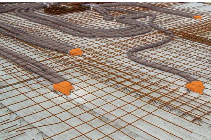
Montaż kanałów R-VENT Flex docelowo zalanych w stropie monolitycznym
