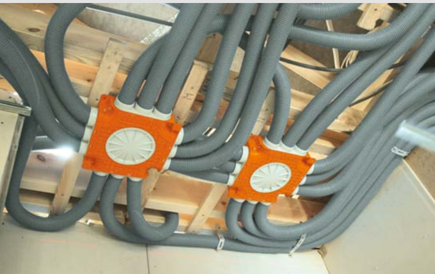
Instalacja R-VENT Flex prowadzona pod stropem drewnianym (docelowo w warstwie izolacji)
